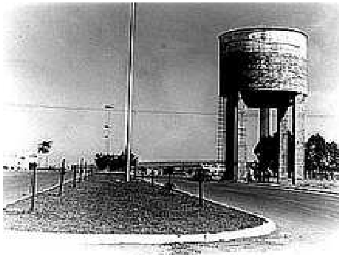
Figura 2- Antiga Caixa d'água no centro de Taguatinga
