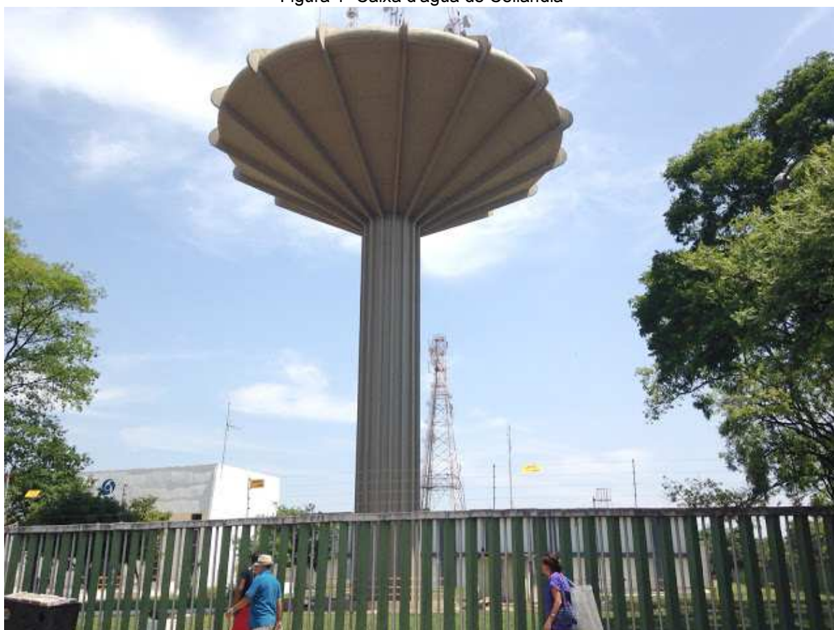
Figura 1- Caixa d’água de Ceilândia
